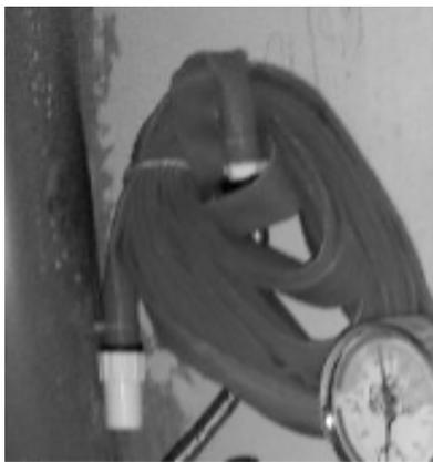
Устройство внутриквартирного пожаротушения КПК
